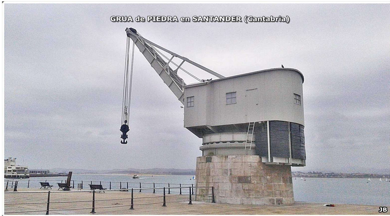
GRUA de PIEDRA - SANTANDER
